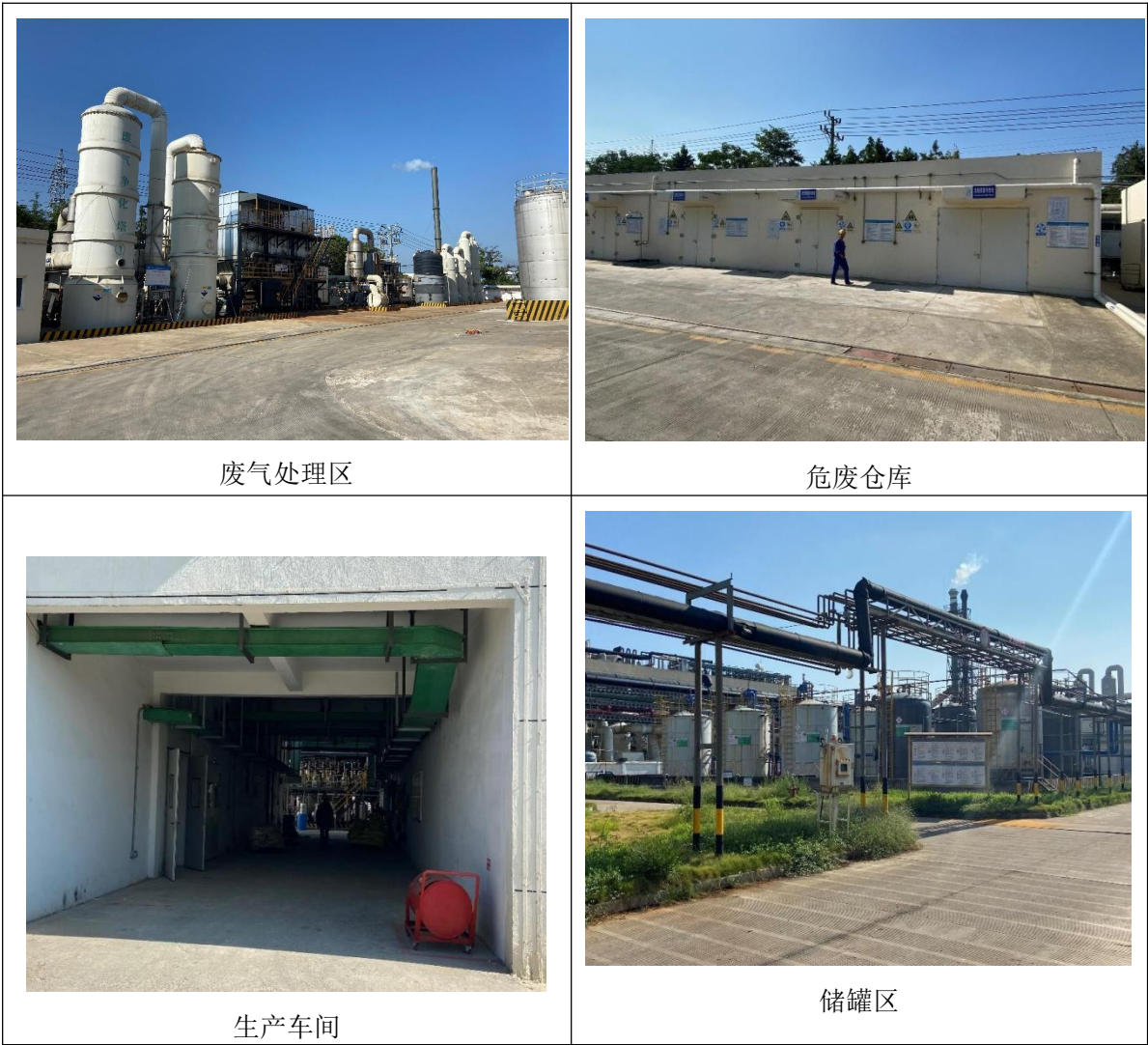
图5.1-1 重点场所及重点设施设备现场照片
